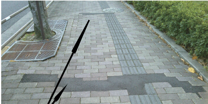
ふれ愛センター北側の“S字の町道”の歩道 桜の根で盛り上がり、補修された箇所
